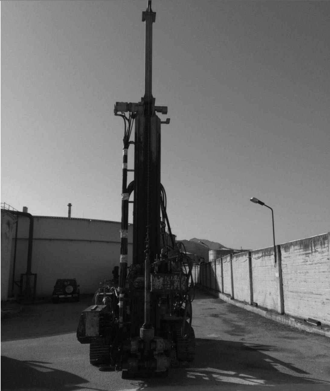
Posizionamento Sondaggio a carotaggio continuo n.3
