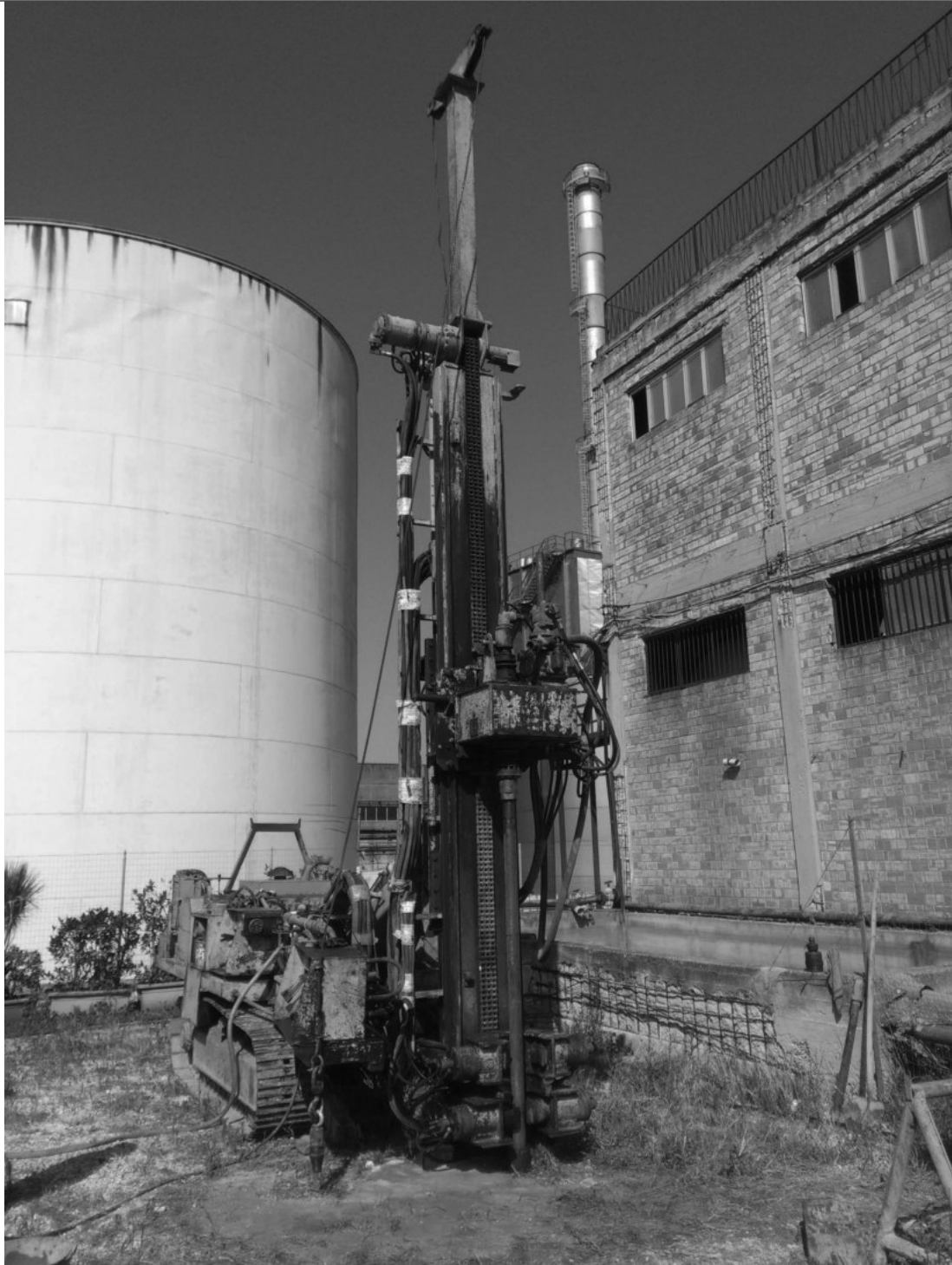
Particolare Sondaggio a carotaggio continuo n.1
