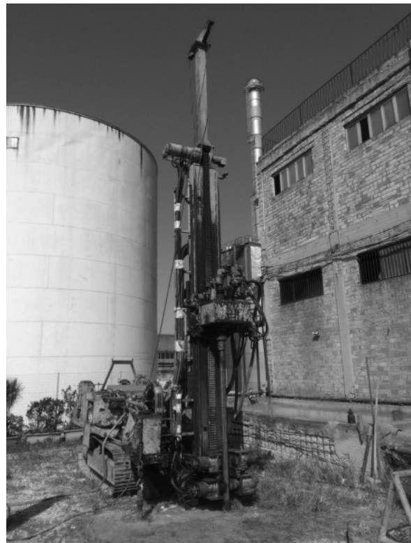
Posizionamento Sondaggio a carotaggio continuo n.1
